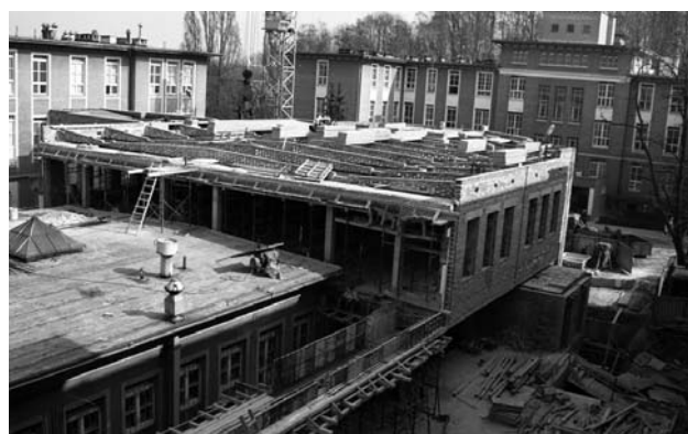
Ryc. 6. Budowa bloku operacyjnego wraz z oddziałem pooperacyjnym
